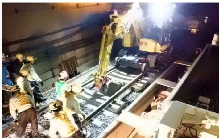
チェーンソーに変えてレスプロソーを導入しました。電動式のため、夜間の騒音低減の他、刃の交換などコスト削減につながり、合成マクラギの切断にも使えるので、今後の作業にも期待しています。
