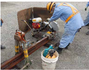
切断機によるレール切断
