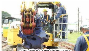
＜軌陸BH載線離線＞
