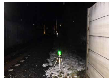
一旦停止位置 緑色回転灯設置状況
