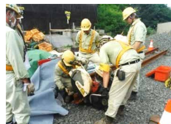
レール切断機、ミニカブ取扱い訓練
