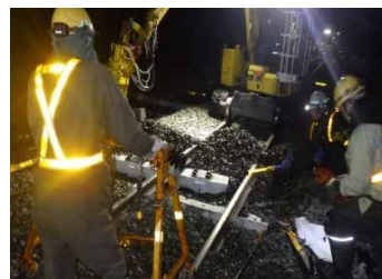
弾性PCマクラギ交換
