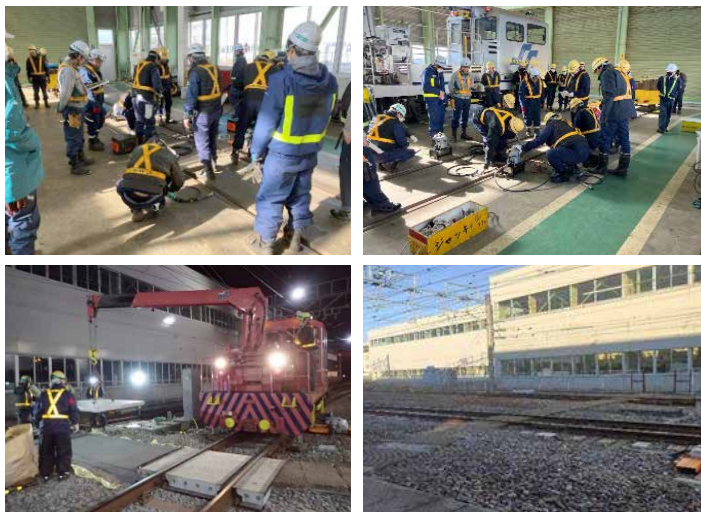
(写真) 総研型連軌敷設の様子
