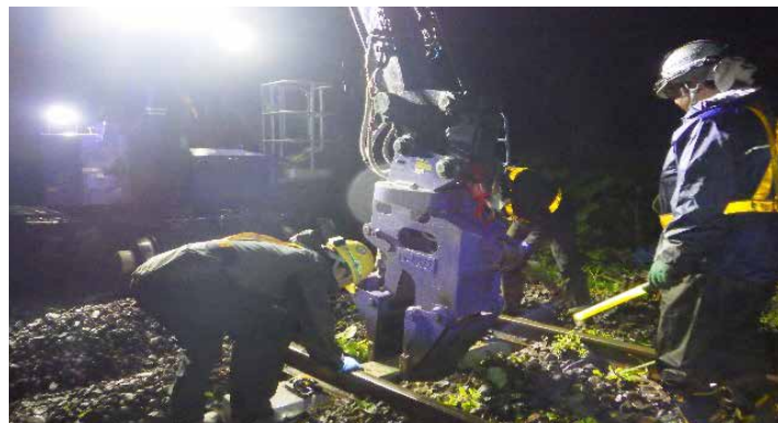
【低コストマクラギ交換】
