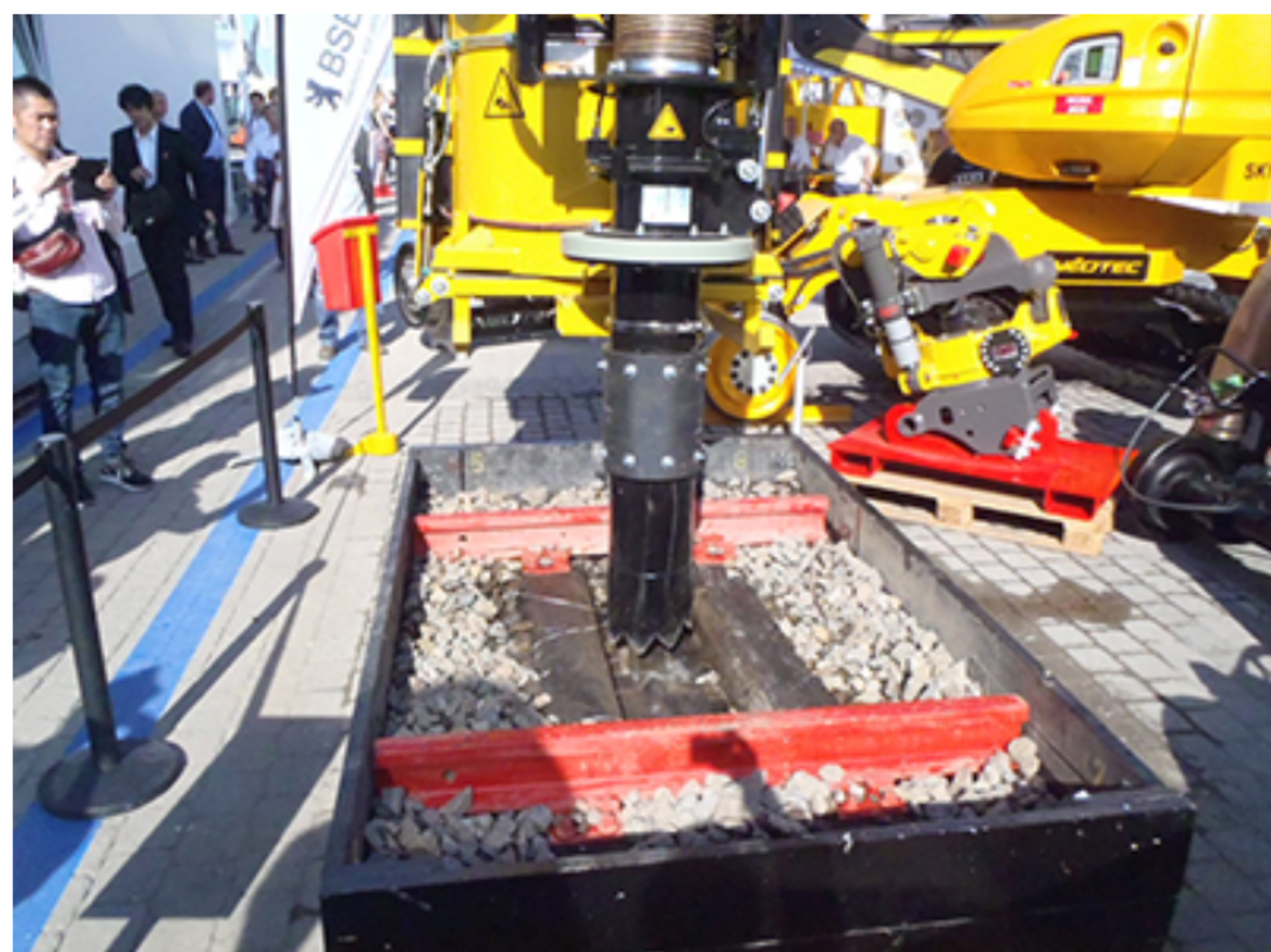
軌陸バックホウによるバラスト吸引機械
