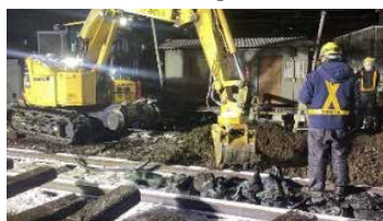
【グラブリングバケットでの路盤整正】
