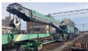
【鉄道クレーン(KRC810N)での分岐器吊上げ】
