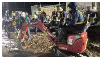
【0.03汎用BHでの路盤整正】
