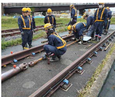
【取扱訓練の状況】
