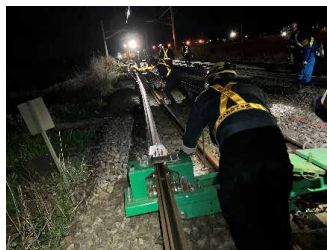
【交換機によるレール交換状況】
