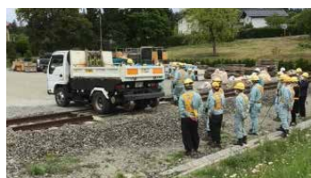
【軌陸車取り扱い訓練】
