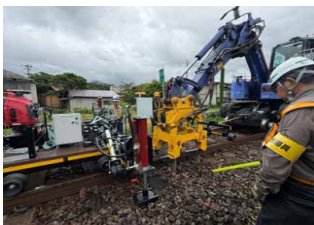
【軌陸BH(四頭TT)+軌きょう扛上装置】
