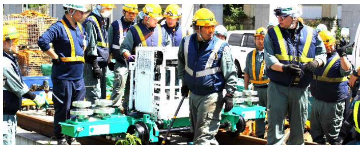
レール交換機取扱い風景
