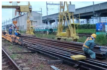
使用レール確認状況
